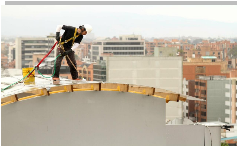
Agosto 29 de 2012 | Trabajador de alturas. Edificio de Biomax. Bogotá
